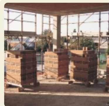
LA DISPOSIZIONE CASUALE DEI BANCALI PUÒ ESSERE UN OSTACOLO PER I LAVORI IN CORSO E AUMENTA IL RISCHIO PER I MATTONI DI ESSERE URTATI ACCIDENTALMENTE
