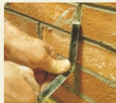
FERRO QUADRO PER LA STILATURA DEI GIUNTI AD ANGOLO O A SGUINCIO
