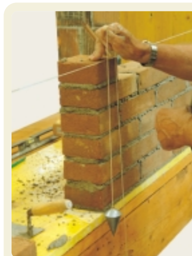
FILO A PIOMBO PER CONTROLLARE LA VERTICALITÀ DEGLI SPIGOLI
