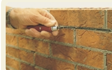
FERRO PIATTO A SEZIONE RETTANGOLARE PER GIUNTI POCO INCAVATI
