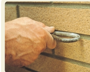
FERRO TONDO PER LA REALIZZAZIONE DI GIUNTI A GOLA
