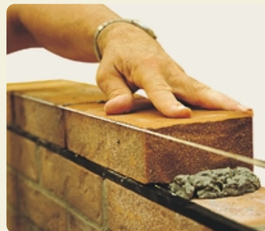
BAIRRA DI FERRO QUADRO (O LISTELLO) PER CREARE GIUNTI INCAVATI
